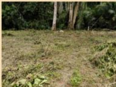
Une vue du désherbage de l'emprise du pipeline au village Nkoayos
