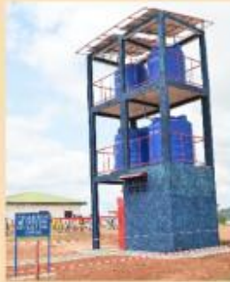
Forage de Nkoteng
