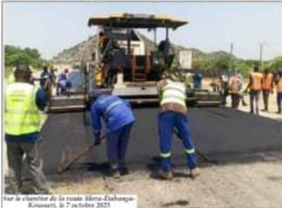
Sur le chantier de la route Mora-Daranga-Kousséri, le 7 octobre 2025
