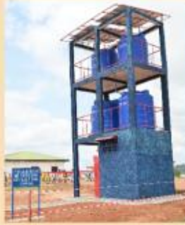
Forage de Nkoteng
