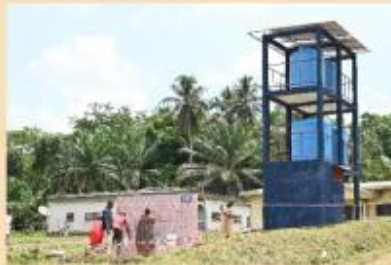
Forage de Bipindi
